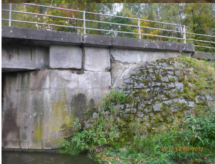
Křídlo opěry 1 vlevo + bok opěry Odpadlá krycí vrstva a povrchová degradace betonu křídla.
